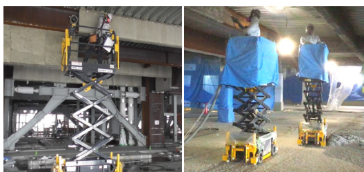
建トウンを用いた施工写真
