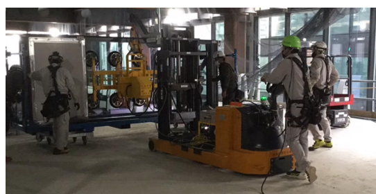
パレットからカーテンウォール取り出し状況
