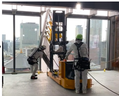
施工時の状況
